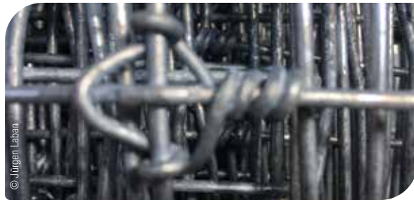
Abb 26 Zaun mit aufgesetzten und nicht-verschiebbaren Knoten
